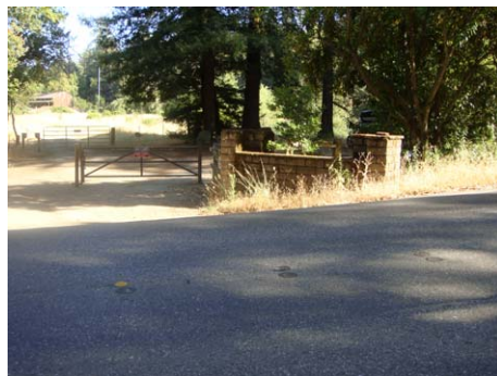
Item 31 090701 Entry gates 001.jpg
