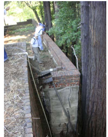
Item 32 090701 Brick Wall 009.jpg
